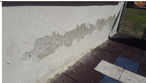
Επιχρίσματα εξωτερικών τοίχων
