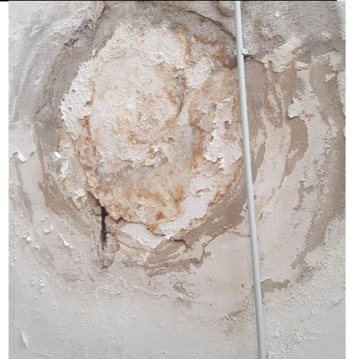
Πλάκα οροφής (εσωτερικά)
