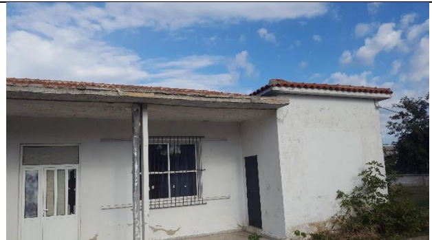
Πλάκα οροφής Η/Χ γυμναστηρίου
