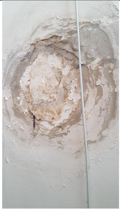
Πλάκα οροφής (εσωτερικά)
