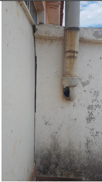
Καμινάδα λεβητοστασίου νηπιαγωγείου
