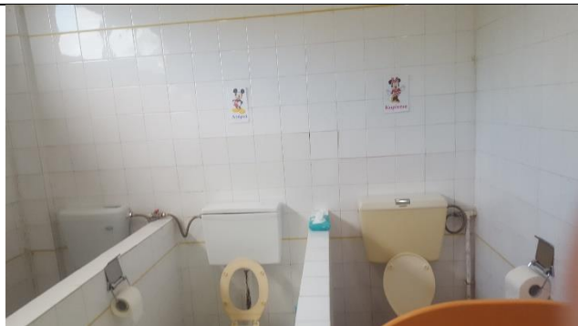
Αποκόλληση πλακιδίων και διαχωριστικοί τοίχοι
