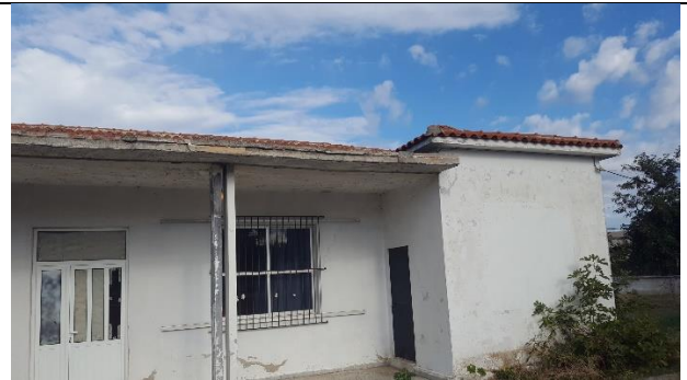
Πλάκα οροφής Η/Χ γυμναστηρίου
