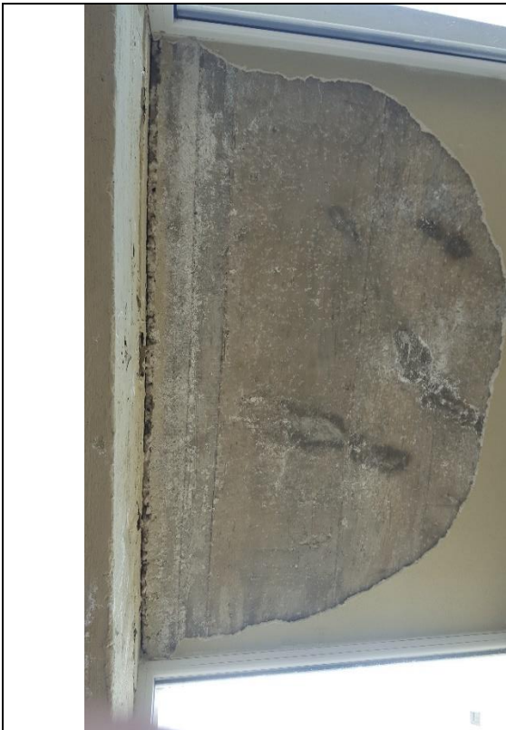
Αποκόλληση επιχρισμάτων στον ανελκυστήρα
