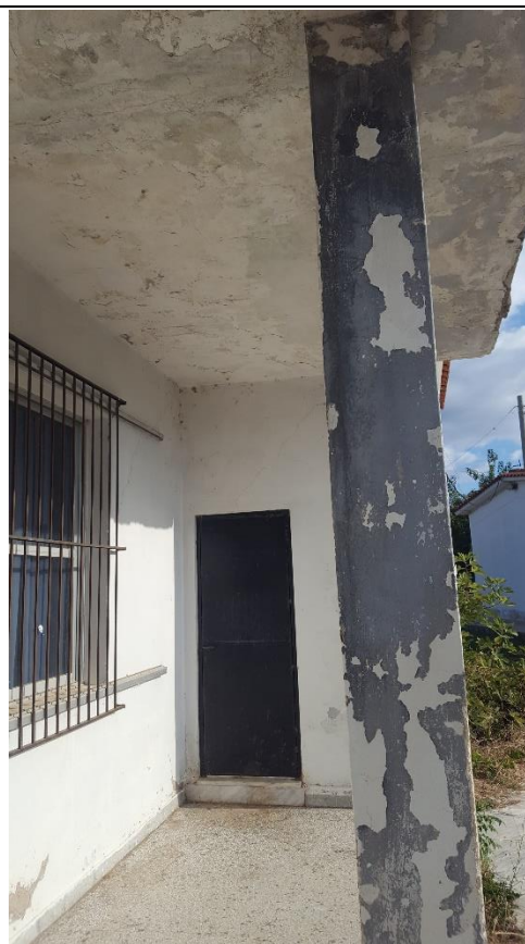
Πλάκα οροφής γυμναστηρίου
