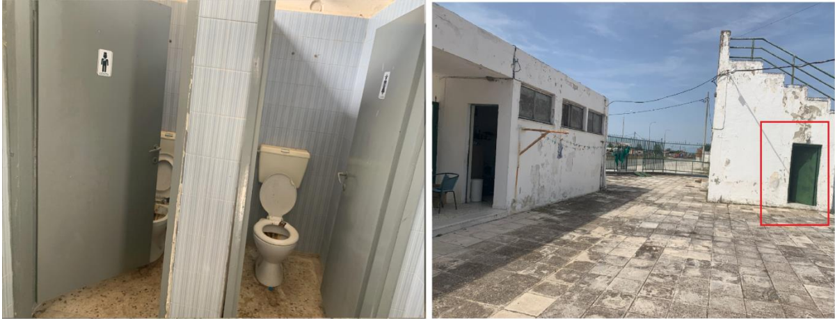
Θέση Λουτρών κερκίδας και εσωτερική άποψη αυτών
