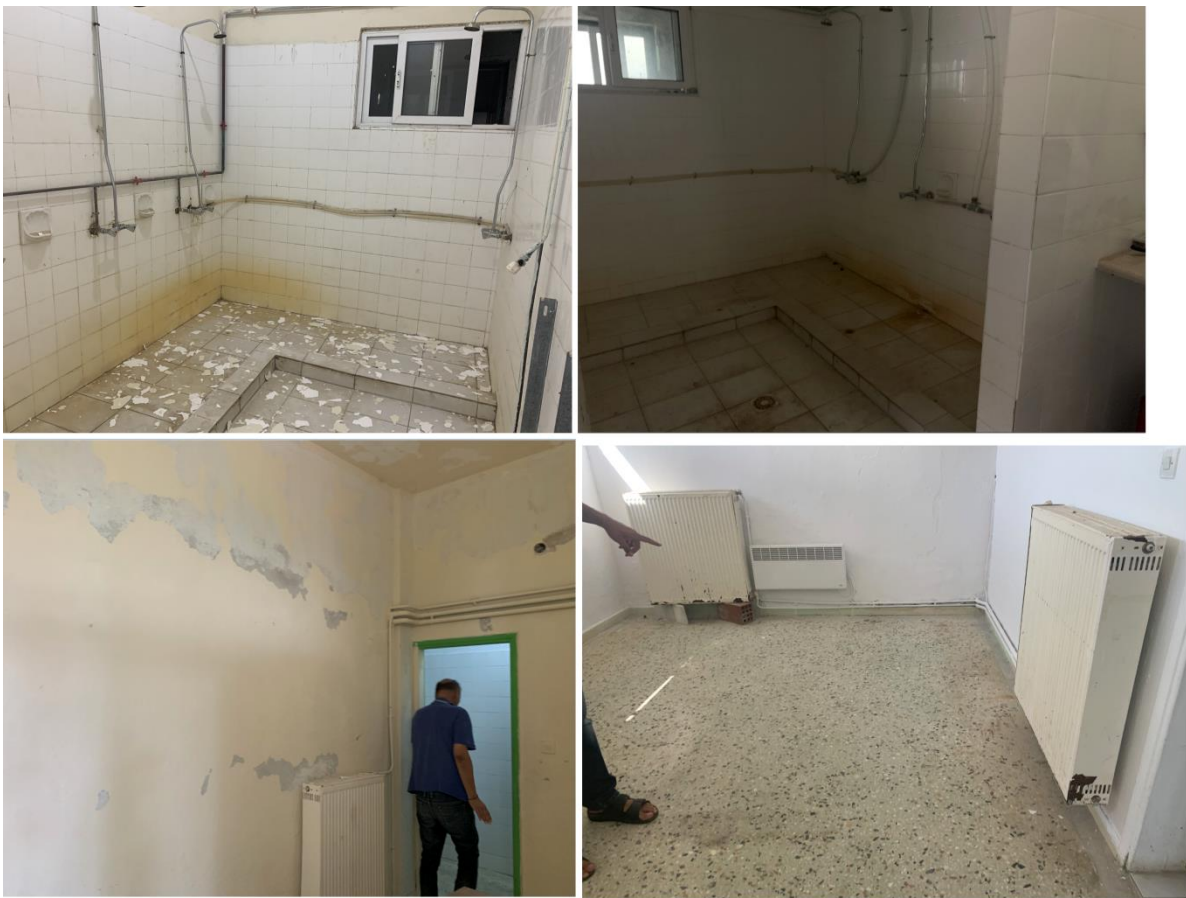
Εσωτερικό του κτιρίου, αποδυτήρια, λουτρά κτλ.
